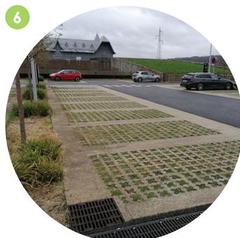
**Stationnements avec ruissellement et insertion des eaux pluviales**
