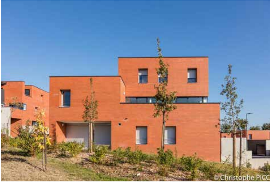
Étages en attique, ZAC Monges à Cornebarieu (31)
