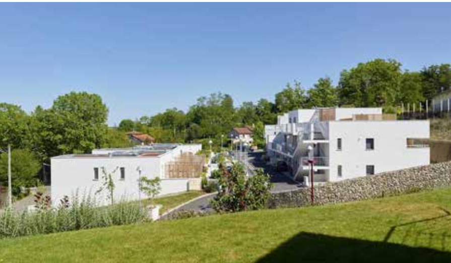
Terrassements et implantation du bâti en escaliers, Taillandier Architectes, Péchabou
