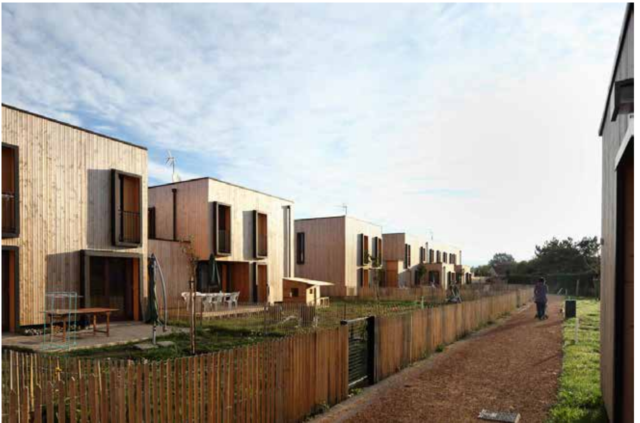
Chemin de circulation pour modes actifs perméable, Simon Teyssou, 20 habitations groupées, Maisons groupées
