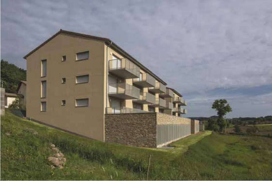
Immeuble collectif dans la pente, Face A, 18 logements collectifs en locatif et accession sociale, hall d'entrée au niveau de la rue et parking en sous-sol, Saint-Clément-les-Places (69), Hauteur R+2, Crédit photo : Mathieu Noël
