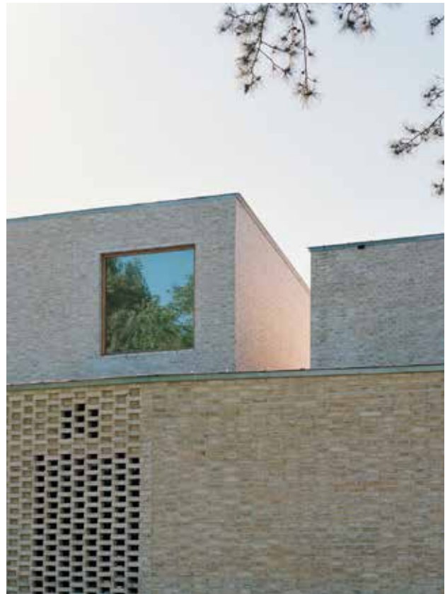
Réutilisation de la brique de manière contemporaine, Espace culturel des pierres blanches, RAUM architectes, Saint-Jean-de-Boiseau (44)
