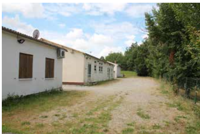
Bâtiments existants et vue du site depuis la route
