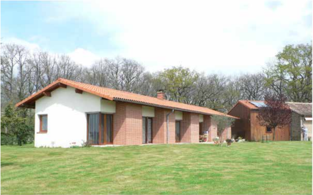
Réutilisation de la brique, des piliers et du toit à double pente typiques du bâti traditionnel de la région toulousaine, Architecte Didier Joyes, maison dans le Frontonnais, Terminée en 2004
