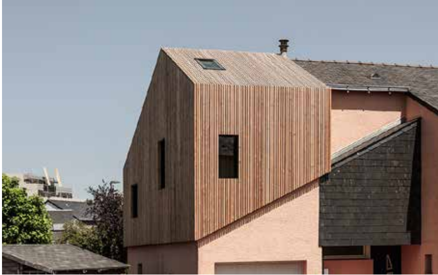
Extension verticale sur maison pavillonnaire, Surélévation LRVO, 44800 Saint-Herblain, VOUS architectes,
