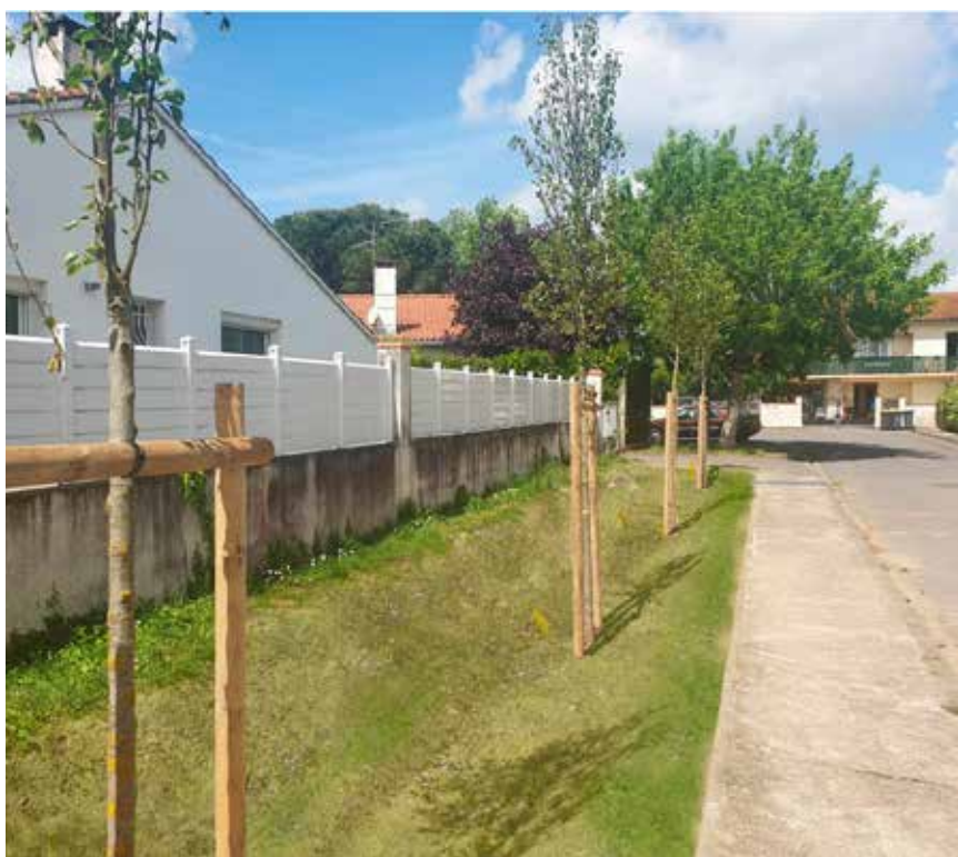
Intégration d'une noue le long des trottoirs, Quartier Renoir_ Portet-sur-Garonne (31)_ATM_2017-2019
