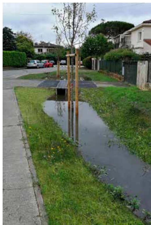
Intégration d'une noue le long des trottoirs, Quartier Renoir_ Portet-sur-Garonne (31)_ATM_2017-2019
