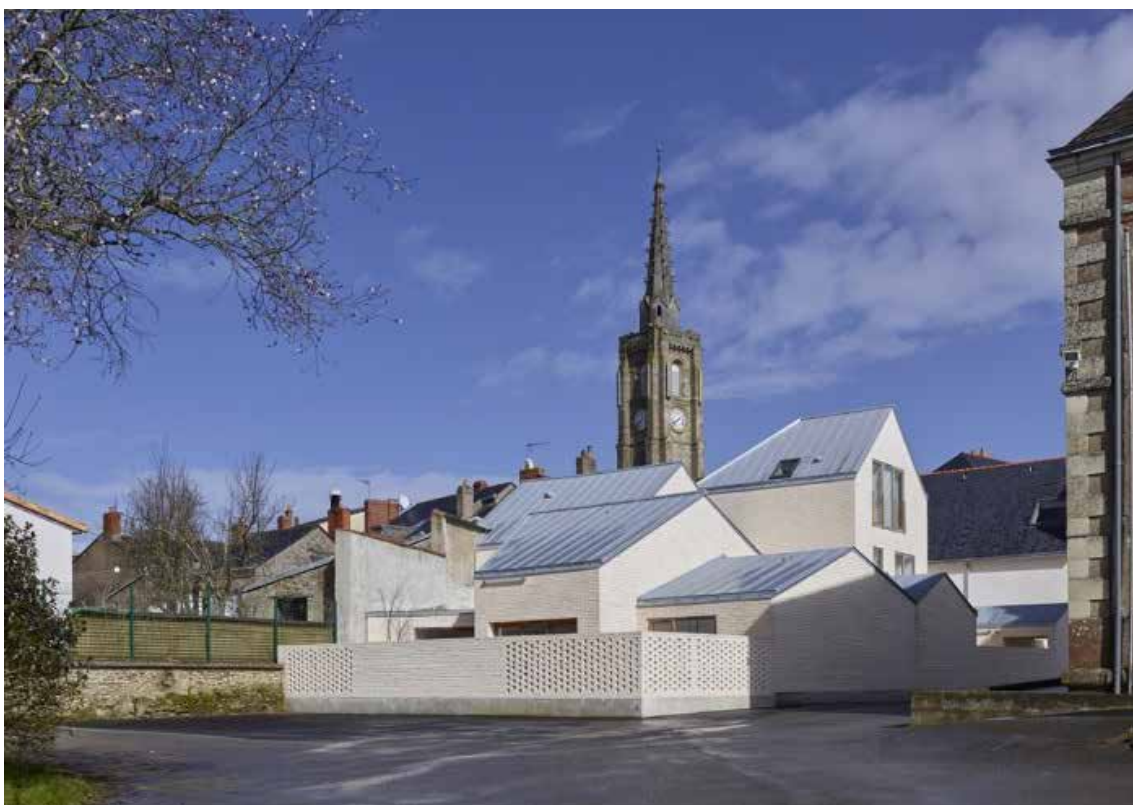
Tact Architectes, 6 logements en réhabilitation + neufs, Mauves-sur-Loire (44)
