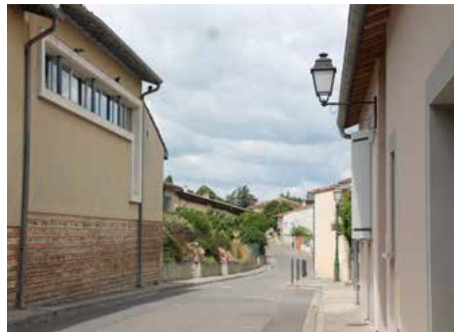
Alternance d'espaces cadrés par des immeubles R+2 et d'espaces ouverts
