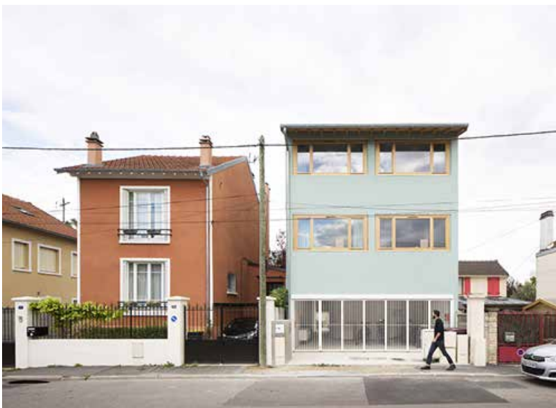
Romainville - Six logements en autopromotion, Lauréat du prix de la première oeuvre 2020, Atelier de l'Hourcq, photos : Clément Guillaume
