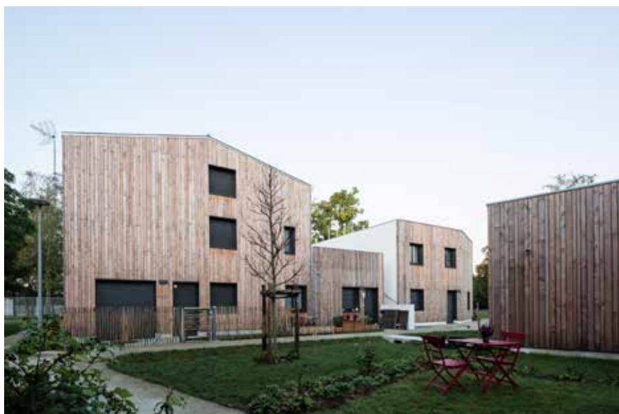
19 logements participatifs, Les champs libres, La Ripossière Nantes (44), Tica architectes
